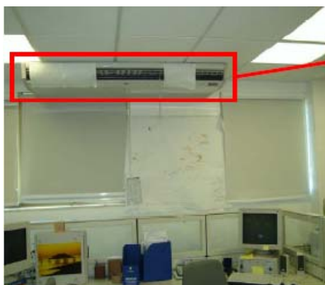
Figura 3.9 – Regulagem improvisada da saída e intensidade de ar
