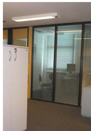
Figura 3.21 – Painéis que dispõem de persianas internas: bom aspecto visual e privacidade ao trabalhador
