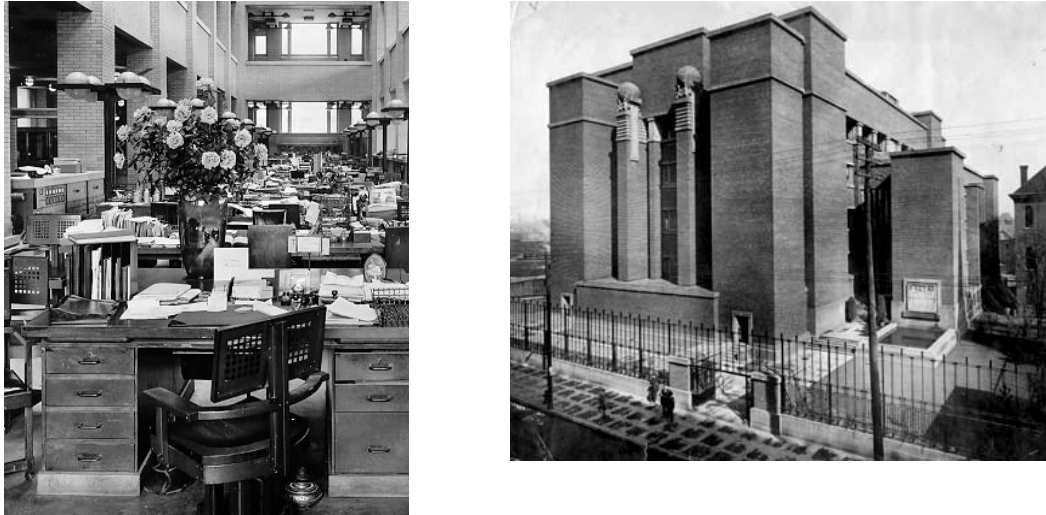
Figura 2.1 – Edifício Larkin : interior e exterior (www.buffalohistoryworks.com)
