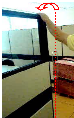
(b) – Divisória inadequada e com problema de fixação.
