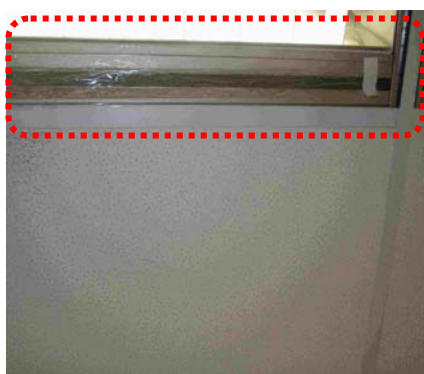
Figura 4.13 – Saída de ar vedada com fita adesiva.
