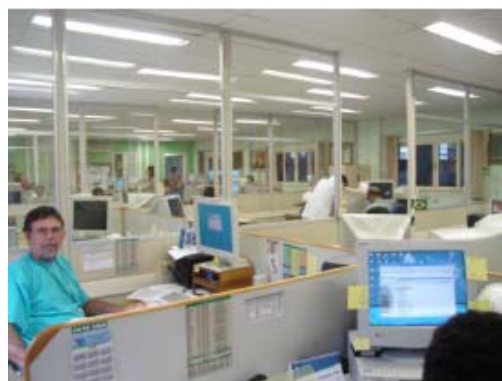
Figura 3.11 – circulação de ar deficiente devido ao posicionamento das divisórias altas
