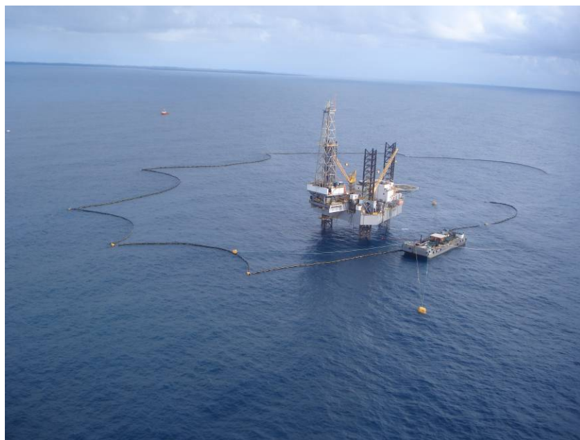
Figura 4.3: Foto aérea do cerco fixo instalado ao redor da plataforma (RCA, 2005)
