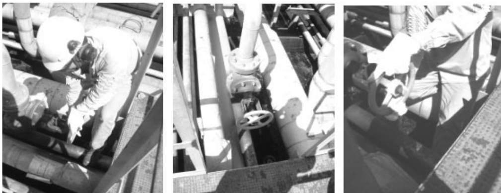
Figura 23 - Estado de manutenção x posicionamento da válvula = constrangimento ao operador
