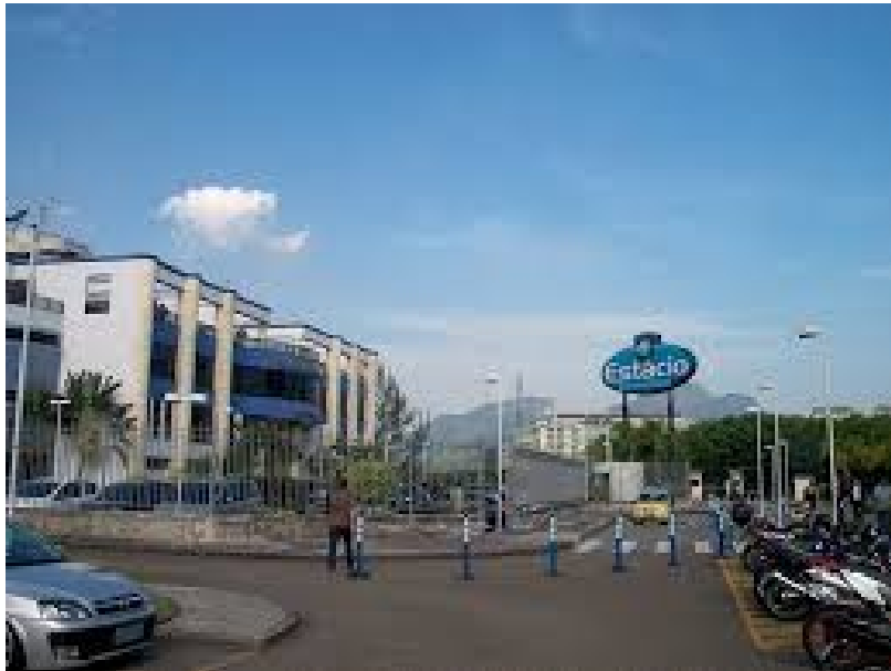
Figura 4.4: Faculdade Y, localizada na Barra da Tijuca, Rio de Janeiro.
