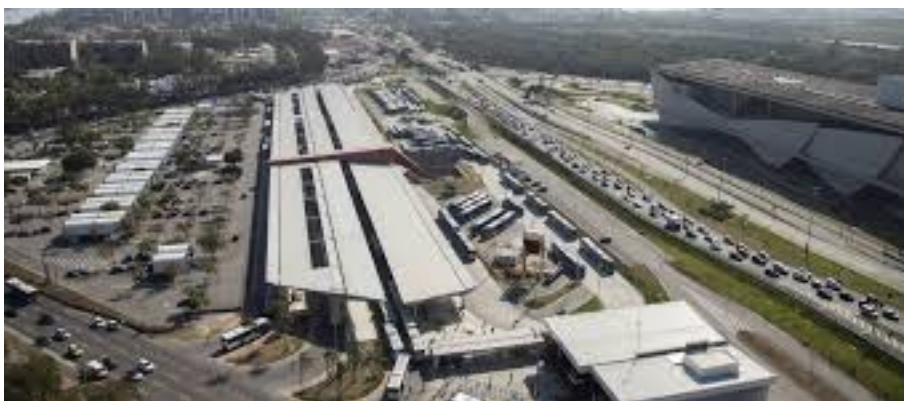
Figura 4.3: Terminal rodoviário Alvorada, localizado na Barra da Tijuca, Rio de Janeiro.
