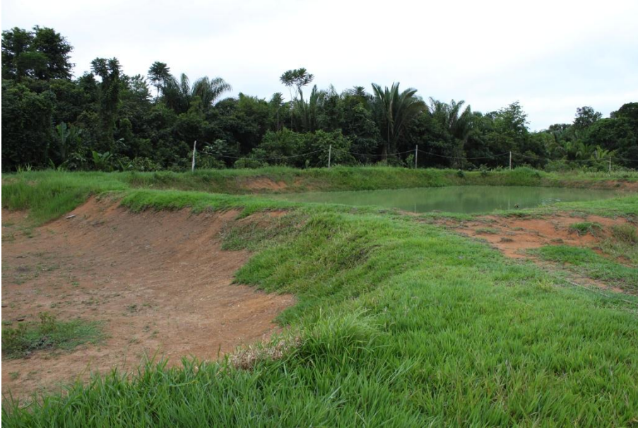
Figura 39 – Tanques escavados com detalhe do talude de separação
