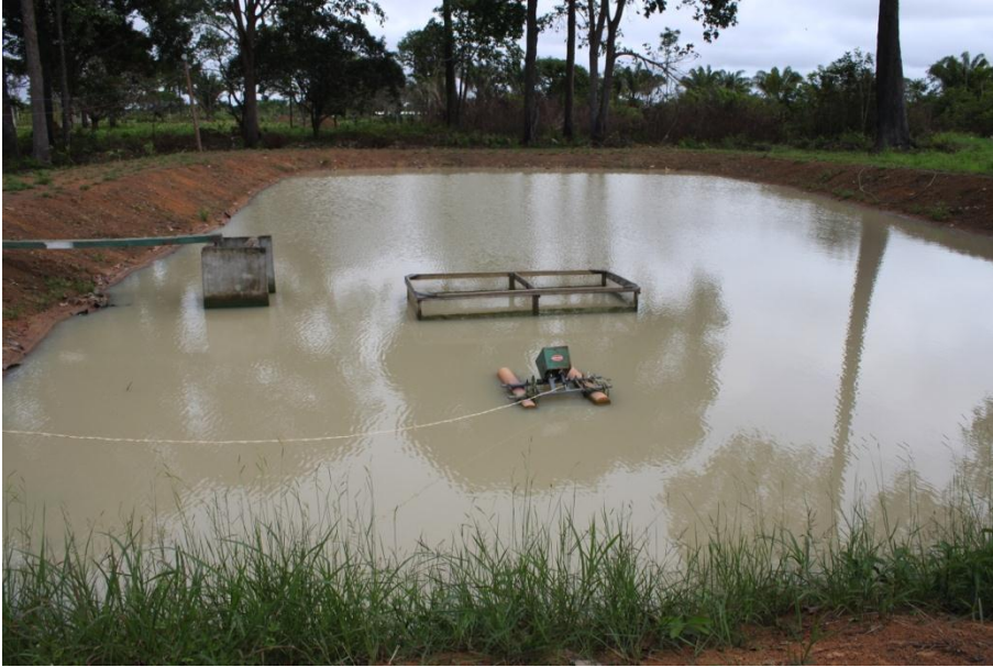
Figura 42 - Tanque escavado de criação de alevinos com detalhe do equipamento oxigenador
