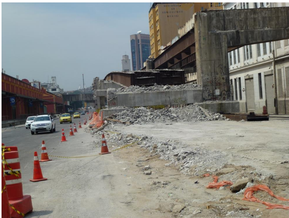
Figura 10 - Demolição do Viaduto da Perimetral, próximo à rua Barão de Tefé, em setembro de 2014. Imagem: Claudia Holanda
