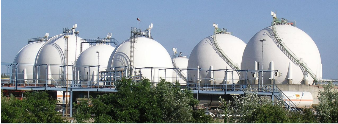
Figura 5.2: Esferas de armazenamento (Fonte: By Ikar.us (Own work, Karlsruhe:Raffinerie) [CC BY 2.0 de], via Wikimedia Commons https://commons.wikimedia.org/wiki/File%3AMiR04.jpg ).
