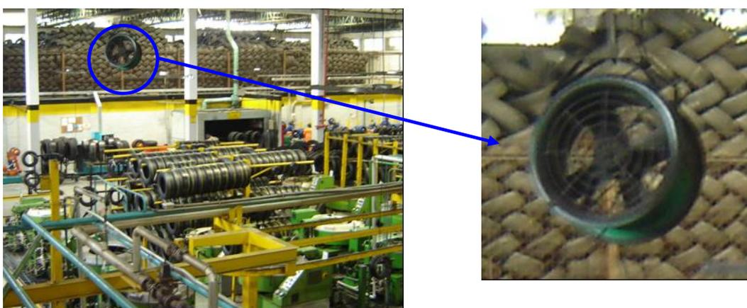
**Figura 41:** Sistema de ventilação do galpão - Ventilador
