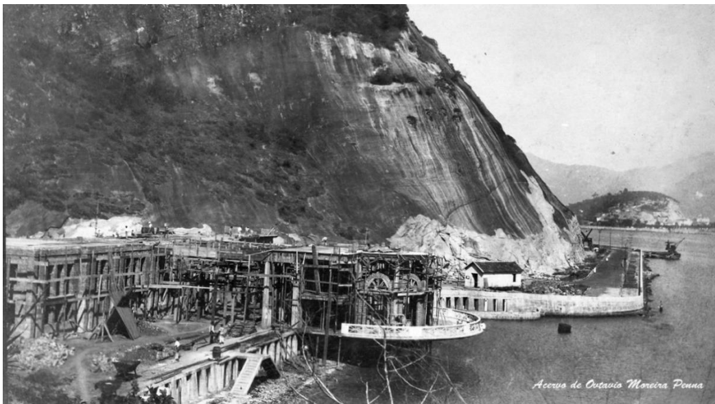
Figura 23. Construção do Hotel Balneário na Urca. Fotografia de Augusto Malta, 1921. Fonte: Acervo Família Otávio Moreira Penna.
