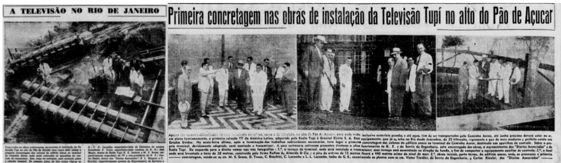
Figura 130. Capa do periódico “A Televisão no Rio de Janeiro”, e matéria “Primeira concretagem nas obras de instalação da televisão tupi no alto do pão de Açúcar” - Estrutura para instalação da antena e máquinas de transmissão no alto do Pão de Açúcar no Rio de Janeiro. O Jornal , ed. 09143, 12 fev 1950. Fonte: Arquivo O Jornal/D.A Press. Acervo digital da Hemeroteca Digital da Fundação Biblioteca Nacional.
