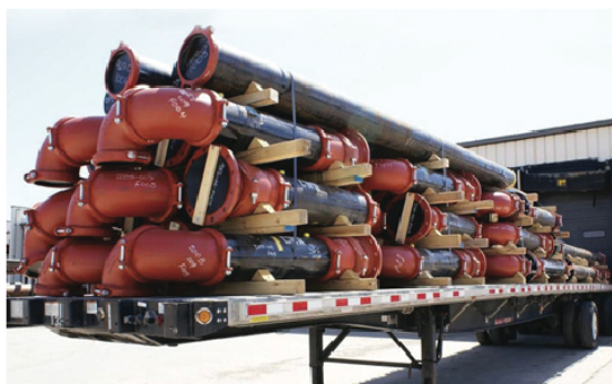
Envio dos Spools para o Site de Montagem
