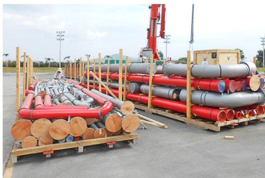
Preservação dos Spools
