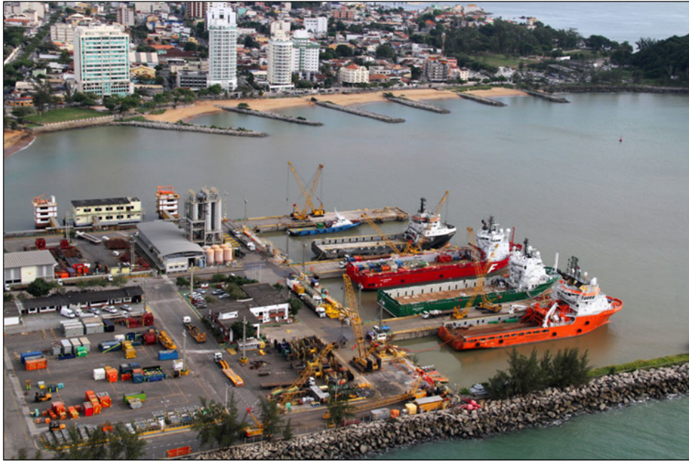
Figura 1.2: Porto de Imbetiba-Macaé/RJ. Fonte: (NET, 2017a)
