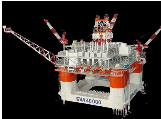
Figura 10. Plataforma Semi-Submersível (ARATANHA, 2005).
