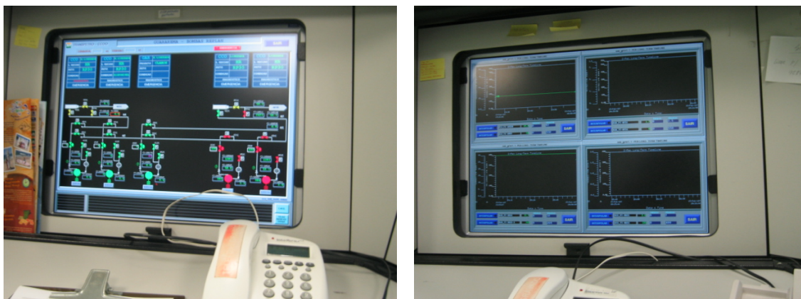
Figura 37 – Displays com reflexões no campo visual do operador.
