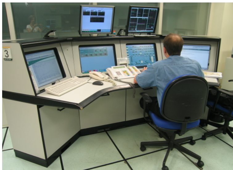
Figura 36 – Estação de trabalho: console com 6 displays .
