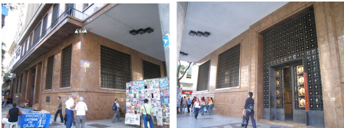
Figura 43 – Imagem das fachadas externas do novo centro de controle
