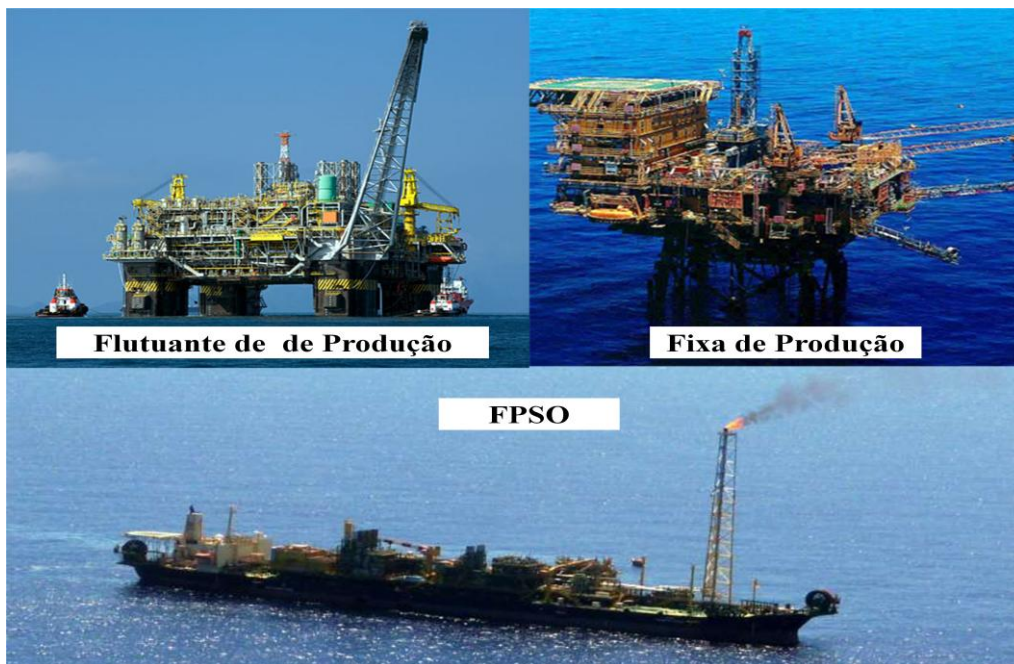
Figura 8: Exemplos de unidades marítimas de produção de petróleo (Fonte: Banco de Imagens Petrobras)
