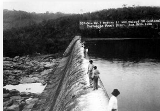
Figura 3 – Barragem de 15 metros da Usina de Parnaíba
