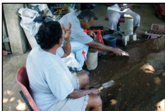
Foto 31 - Postura forçada na execução da atividade
