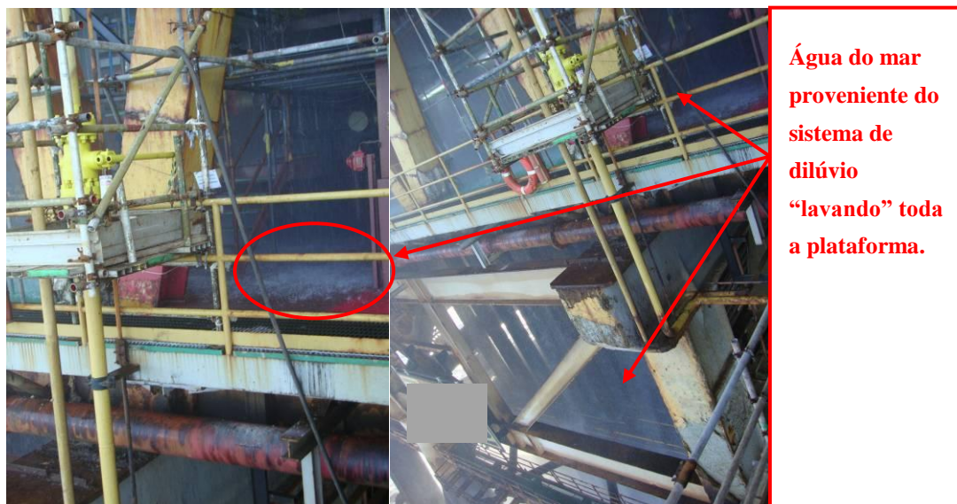
Figura 24 – Teste do sistema de dilúvio de P-F
