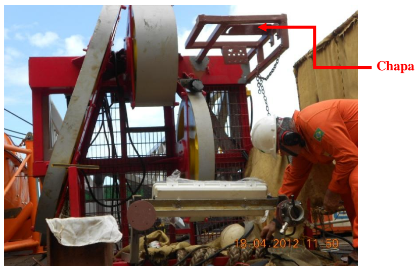
Figura 20 – Desempeno de chapa realizado pelo soldador da equipe de sonda
