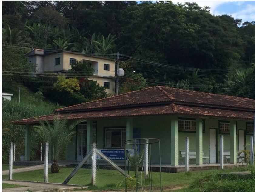
Figura 4: Fachada da USF Caiçaras
