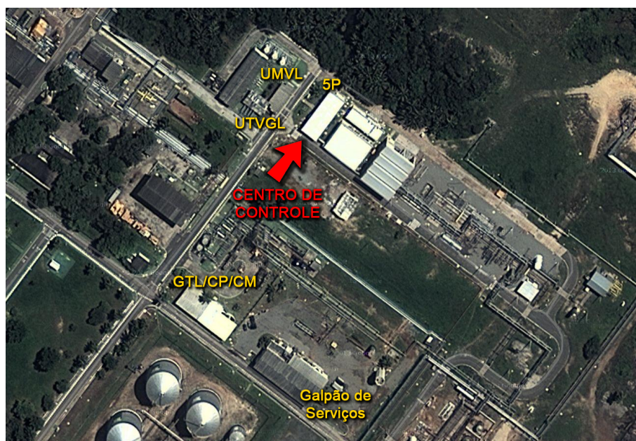
Figura 9: Salas de controle local e espaço destinado ao novo CIC
